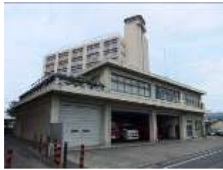
桐生市消防本部 桐生消防署東分署
