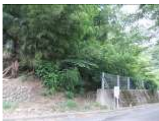
急傾斜地崩壊危険箇所（対策工事済）
