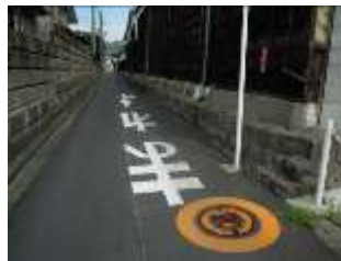
消火栓遠景(丸型)
