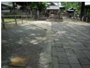
桐生天満宮内消火栓
