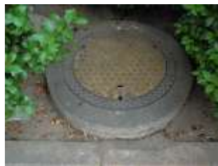
防火水槽近景
