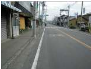
消火栓遠景(四角型)
