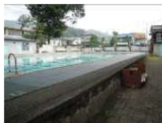
防火水槽(北小学校プール)
