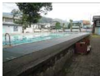
⑦北小学校プール
