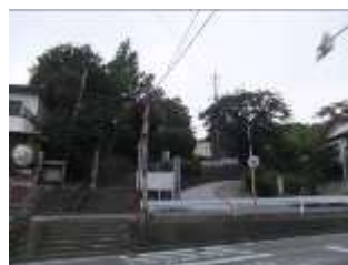
急傾斜地崩壊危険箇所
