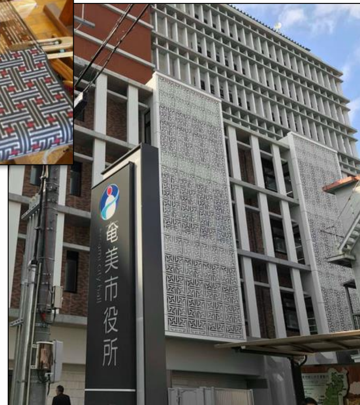
奄美市役所 外壁
