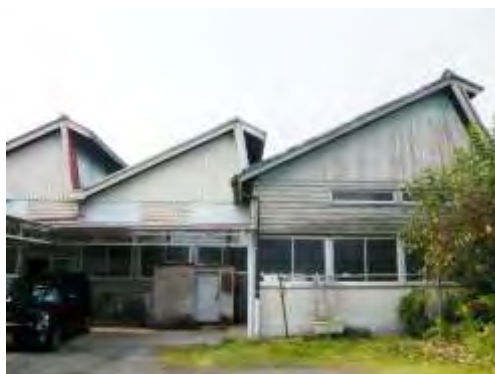
ノコギリ屋根工場
