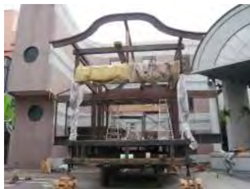
組み立て中の屋台
