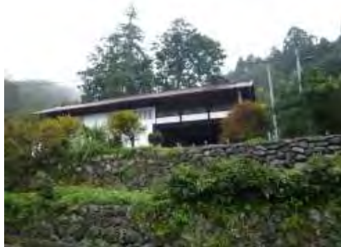
現在の旧水沼製糸所長屋門
