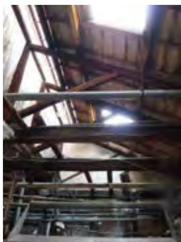
小池染色 (ノコギリ屋根工場内部)
