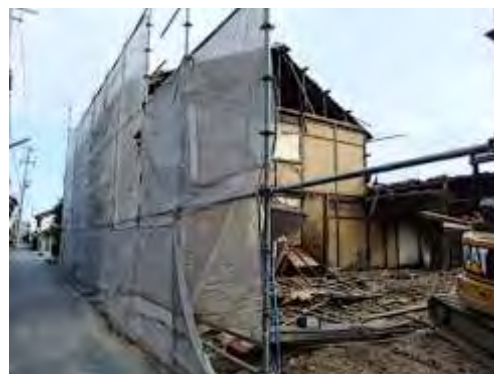
解体される歴史的建造物（他都市）
