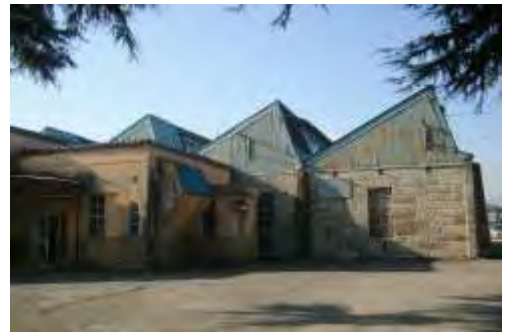
ノコギリ屋根工場
