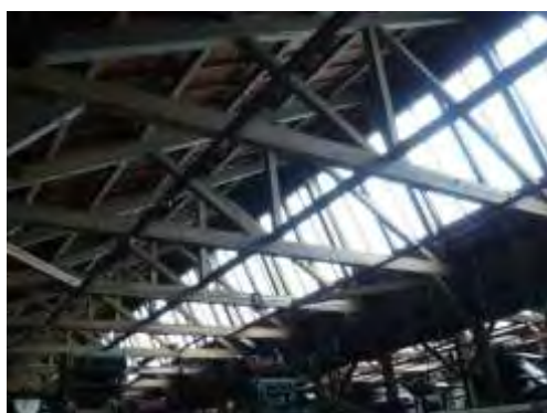
北側に採光窓のある工場内部
