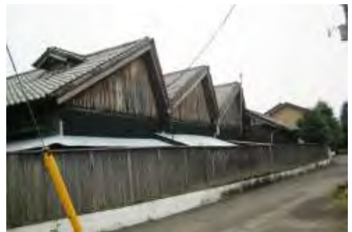
ノコギリ屋根工場
