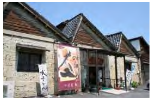
ノコギリ屋根工場
