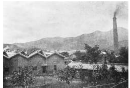
日本織物株式会社ノコギリ屋根工場
