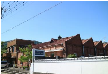
指定第15号「旧株式会社金芳織物工場事務所及び鋸屋根工場」
