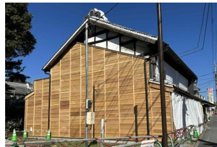
工事状況 外部
