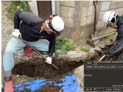
4月 電線共同溝工事
