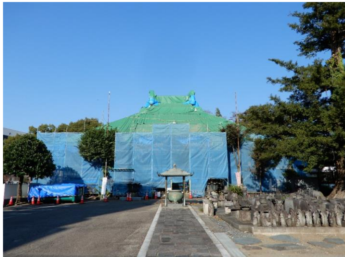
浄運寺本堂 屋根葺き替え・耐震壁導入工事
