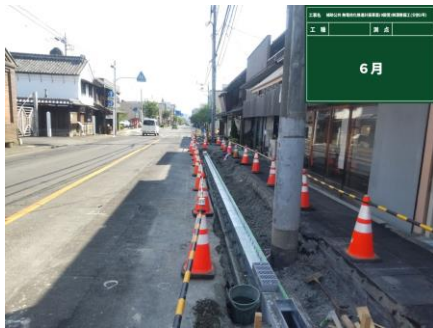
6月 側溝整備工事
