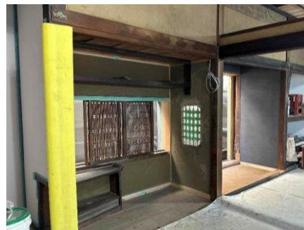
工事状況 内部
