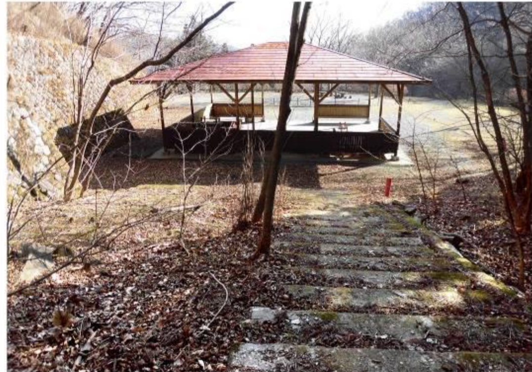
プラットホーム跡（東屋背面）
