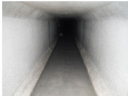
□800mm × 800mm 雨水渠の内部の様子
