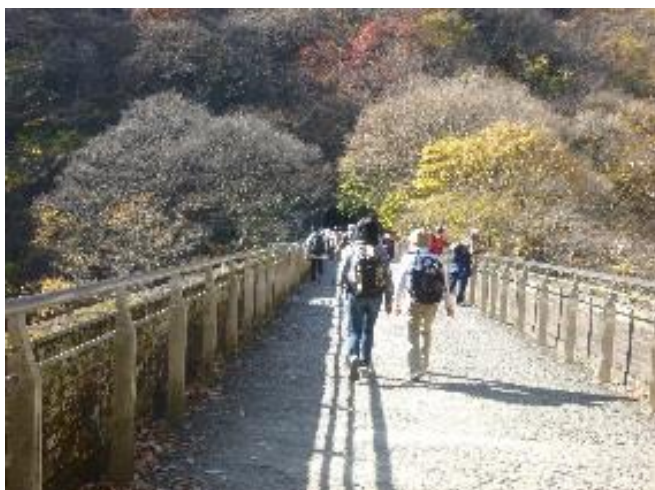
碓氷第3橋梁（めがね橋）を渡っています。
