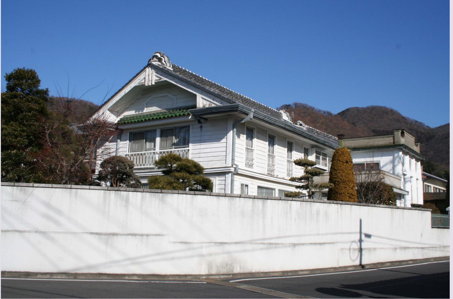
木造2階建切妻造瓦葺 主屋南東側（サロン）外観 突出する玄関に平屋の応接が連なる。
