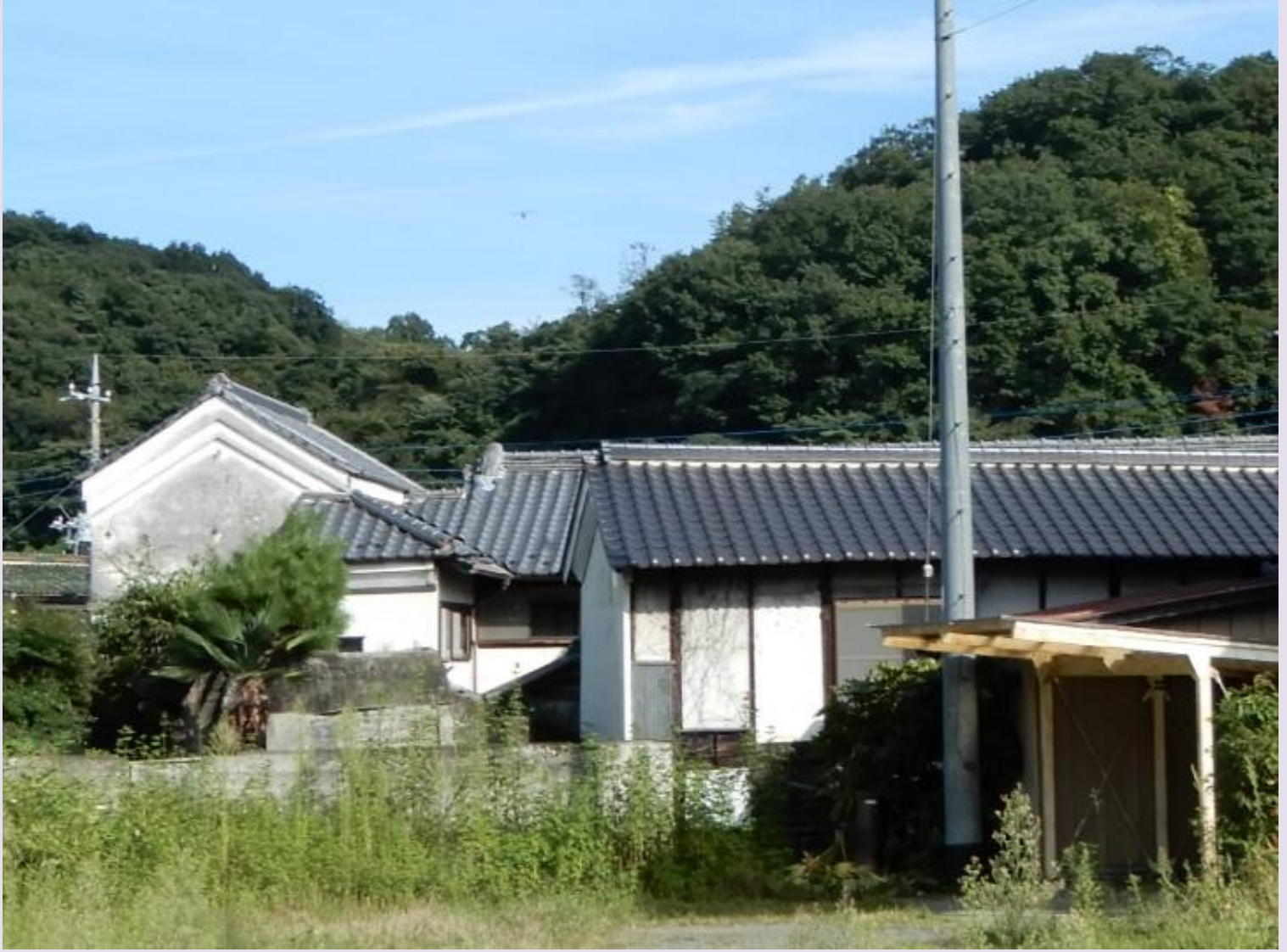
蔵と奥座敷 北西面
