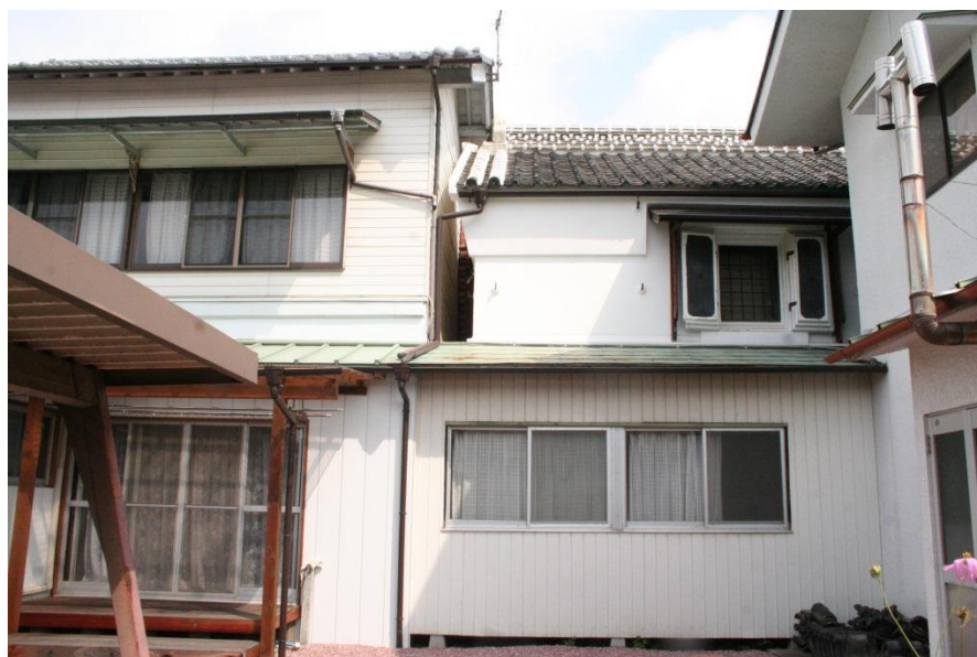
土蔵及び新座敷南面
