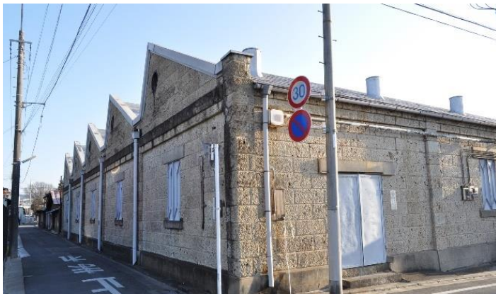
桐生新町伝統的建造物群保存地区 旧曾我織物工場
