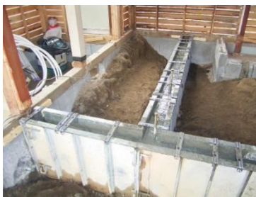
耐震改修(基礎新設)
