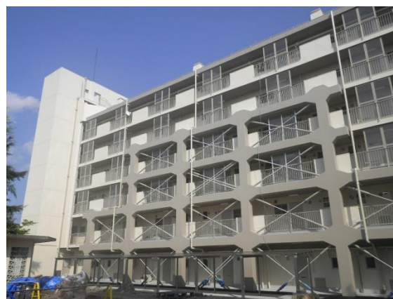
耐震改修（浜松町1丁目団地）
