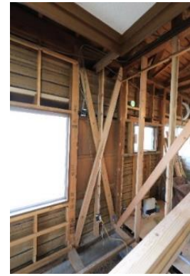
耐震改修(筋かい)
