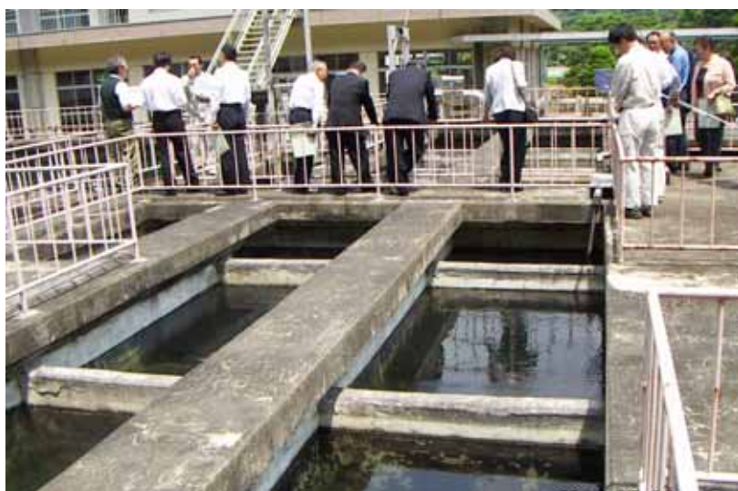
一般の市民による水道施設見学
