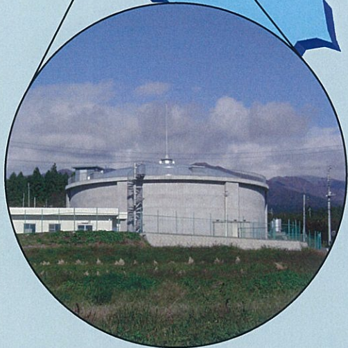
新里第10配水場
