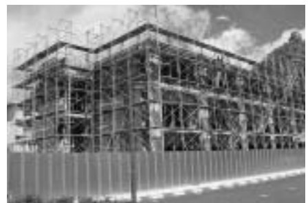
(改修中の県営住宅)
