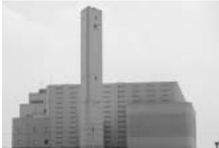
(広域清掃センター)
