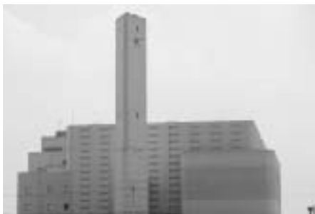
(広域清掃センター)
