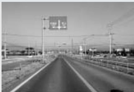
(拡幅工事中の道路)
