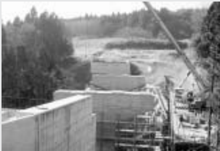
(建設中の道路)
