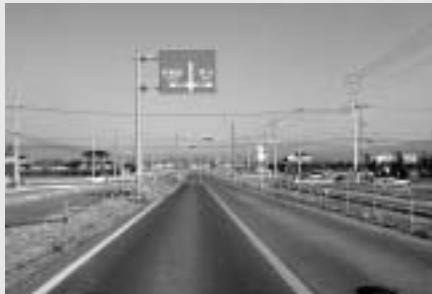
(拡幅工事中の道路)
