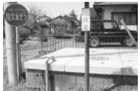
(新里町内の防火水槽)
