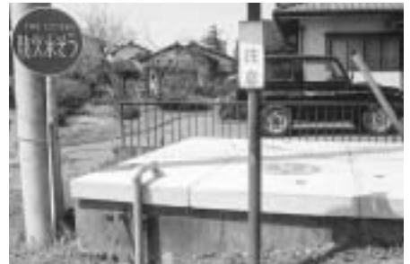
(新里町内の防火水槽)
