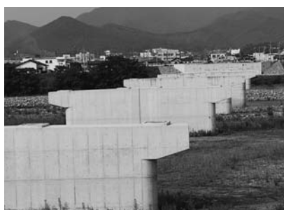
（仮称）中通り大橋の橋脚
