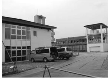
(建設中の〈仮称〉桐生西消防署)
