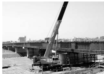
(整備が進む「仮称」中通り大橋)
