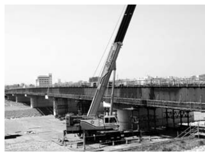
(整備が進む「仮称」中通り大橋)
