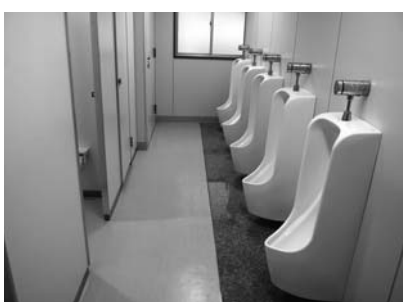
（改修済みのトイレ）
