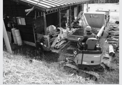
(除染作業風景)
