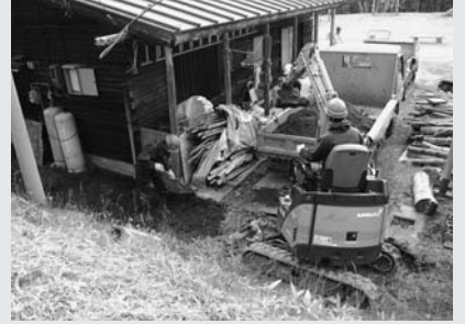
(除染作業風景)
