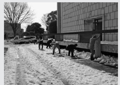
(除雪作業の様子)
