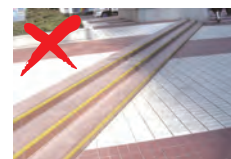
白は眩しく、赤茶との明度差が大きいため、平らに見えにくく、段差が危険 (東京都)
