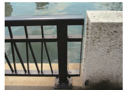
水面の色が映える橋梁の色（台東区）
