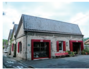
美容室 Ash・旧堀祐織物工場 国登録文化財 (巴町一丁目)
