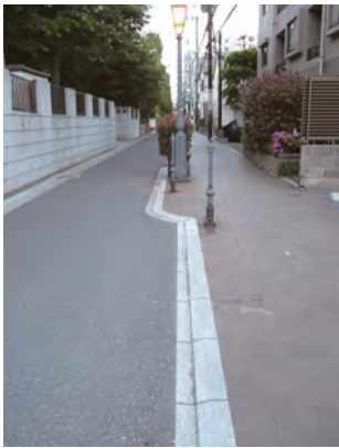
落ち着いたレンガ調タイルの歩道（さいたま市）
