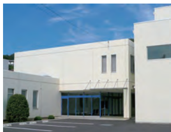
単調になりやすい白壁面に入口部分の青が効果的 (堤町三丁目)
