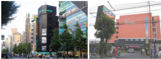
周辺のまち並み景観から突出した店舗（東京都）
