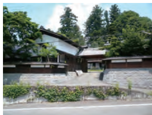
下田家住宅 新里町板橋 石・木材・漆喰等、自然素材を用いた落ち着いた色づかいにより、周辺の木々や田畑、山々等の環境と調和
