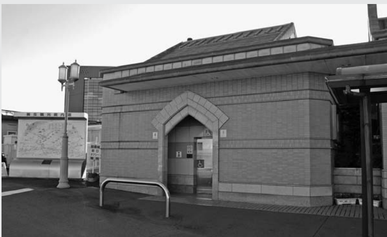
(新桐生駅公衆トイレ)
