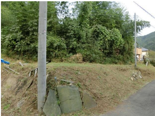
南側が道路となっている
