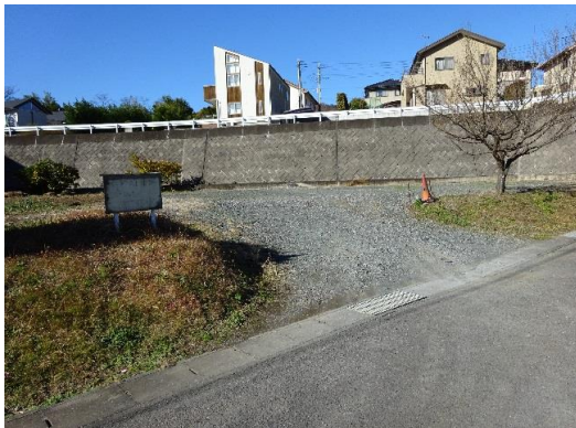
敷地入り口写真 東道路に接道
