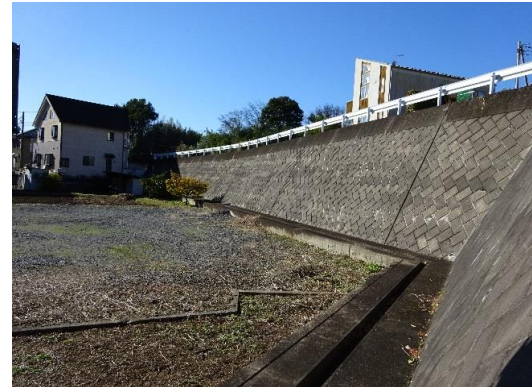
敷地西側から北側は擁壁に囲まれている
