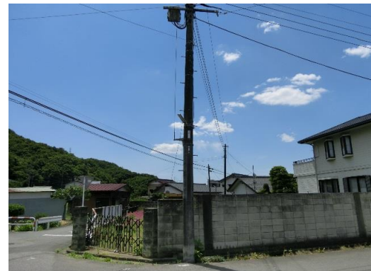
北側はブロック塀で囲まれている
