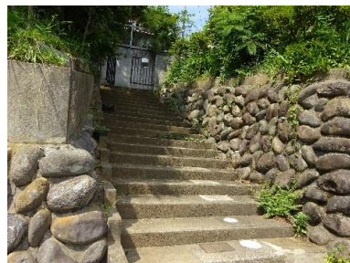
敷地進入部分
