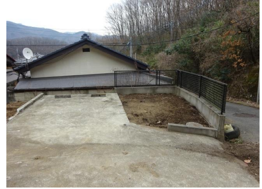
敷地南東側に駐車スペースの舗装跡あり
