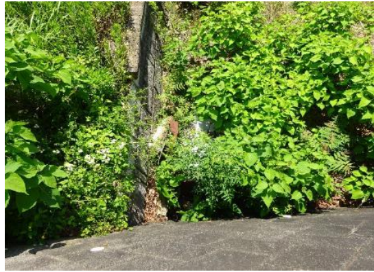
東側隣地との境界 低いブロック塀あり
