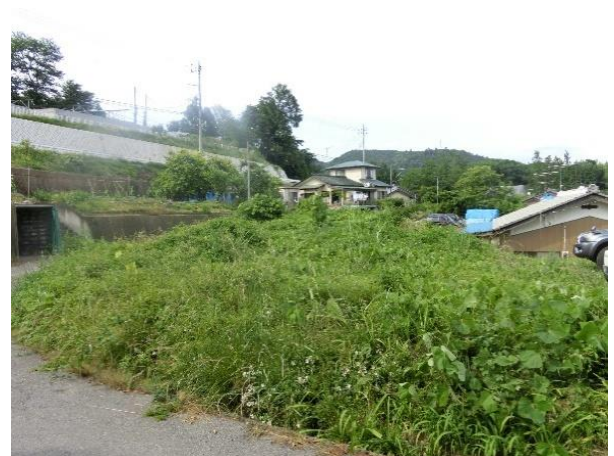
西側2項道路から見た544-40との境界あたり 敷地北角、がけ規制対象の可能性あり
