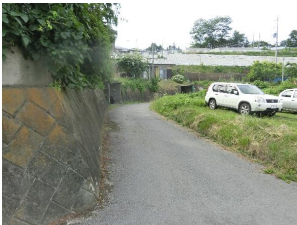
敷地西側の2項道路 建築時には狭あい協議が必要
