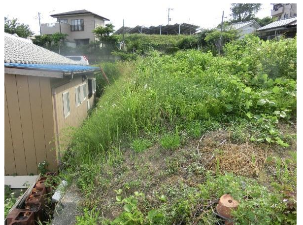
544-40東端部分 がけ規制対象の可能性はある
