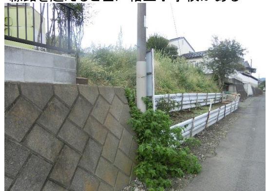
敷地の東側から撮影②
