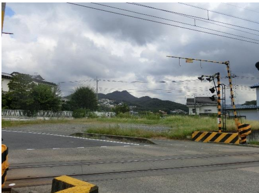
敷地の南側は上毛電気鉄道の線路
