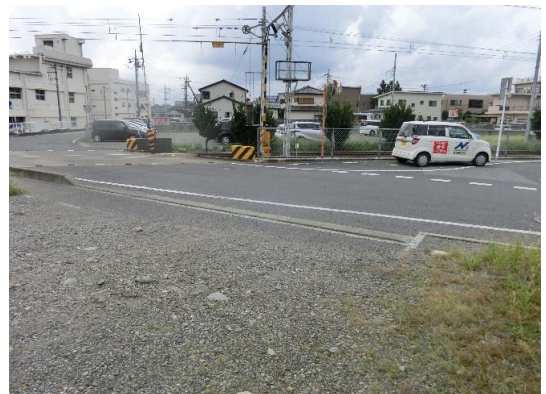
敷地から南側を撮影 線路を越えると左に相生小学校がある
