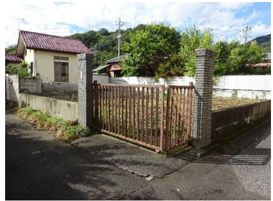
門扉と外壁が一部残っている
