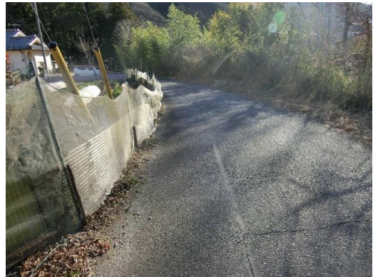
西側接面道路。 本道路の西側には桐生川が流れる。
