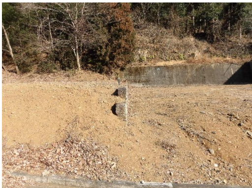
道路から見た敷地内の段差
