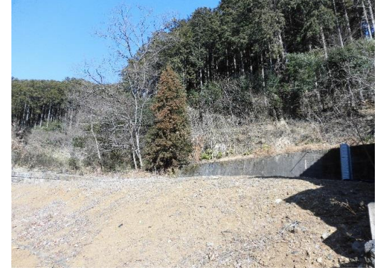
南側から見た敷地
