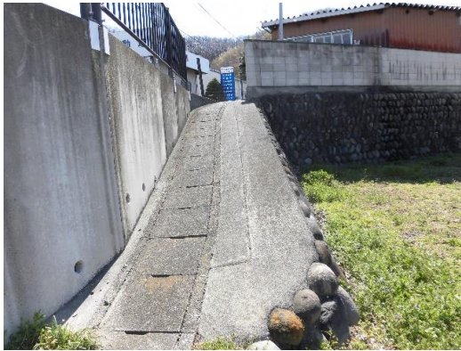
県道から敷地への侵入口
