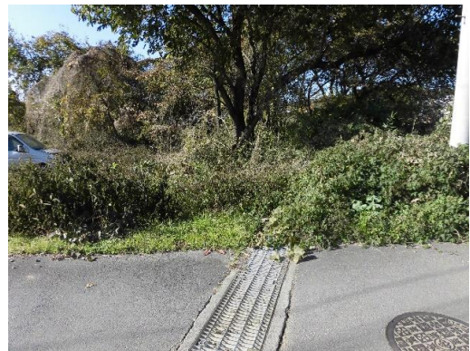
敷地侵入部分 上下水道の引込なし
