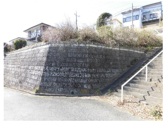
東側から見た敷地の擁壁
