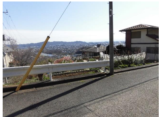
敷地前、道路北側に電柱有り
