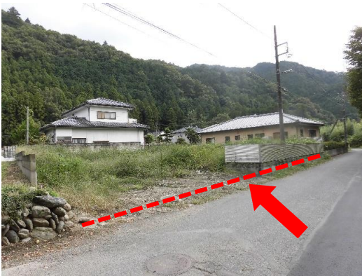
敷地の西側の道路から撮影
