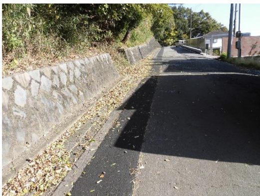
敷地下側の南側道路
