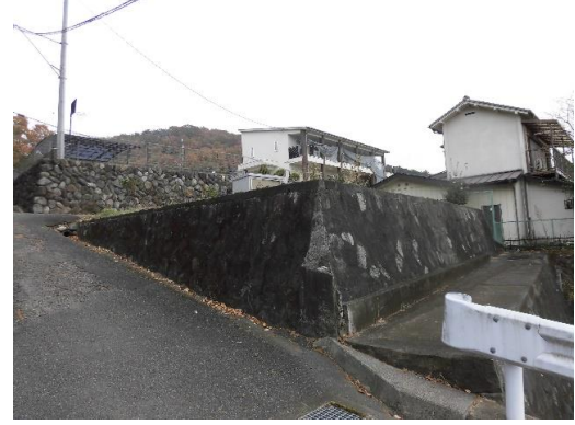
敷地南側の擁壁
