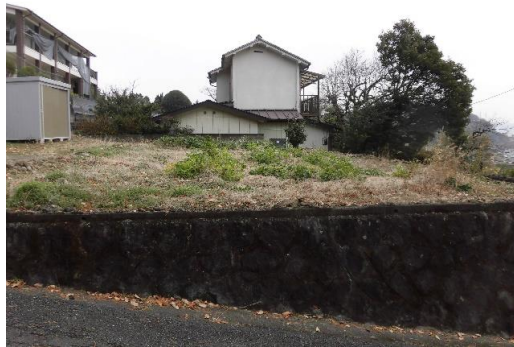
敷地写真 ひな壇造成地となっている
