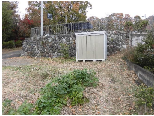
敷地北側の擁壁
