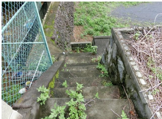
敷地南側辺りに設けられた階段
