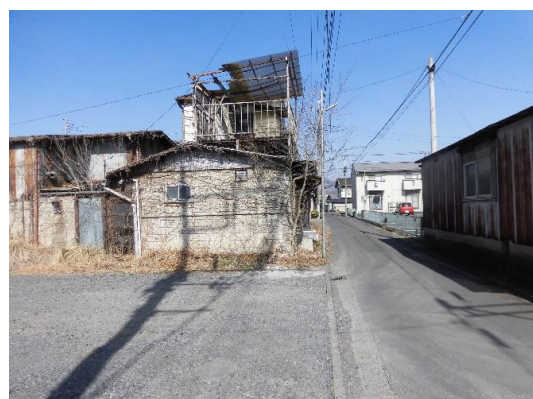
敷地前道路(南東側に接する2項道路)
