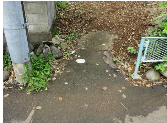
敷地侵入部分 写真右のフェンス部分には水路有り
